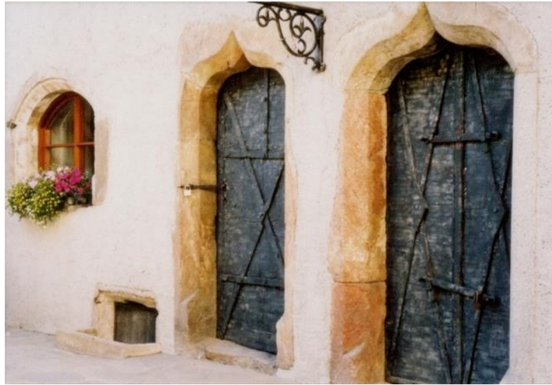
Kielbogentüren im Hoftrakt des Rathauses von Obervellach
